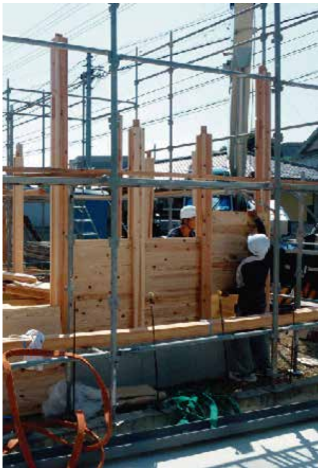
Jパネルの壁を落とし込む
