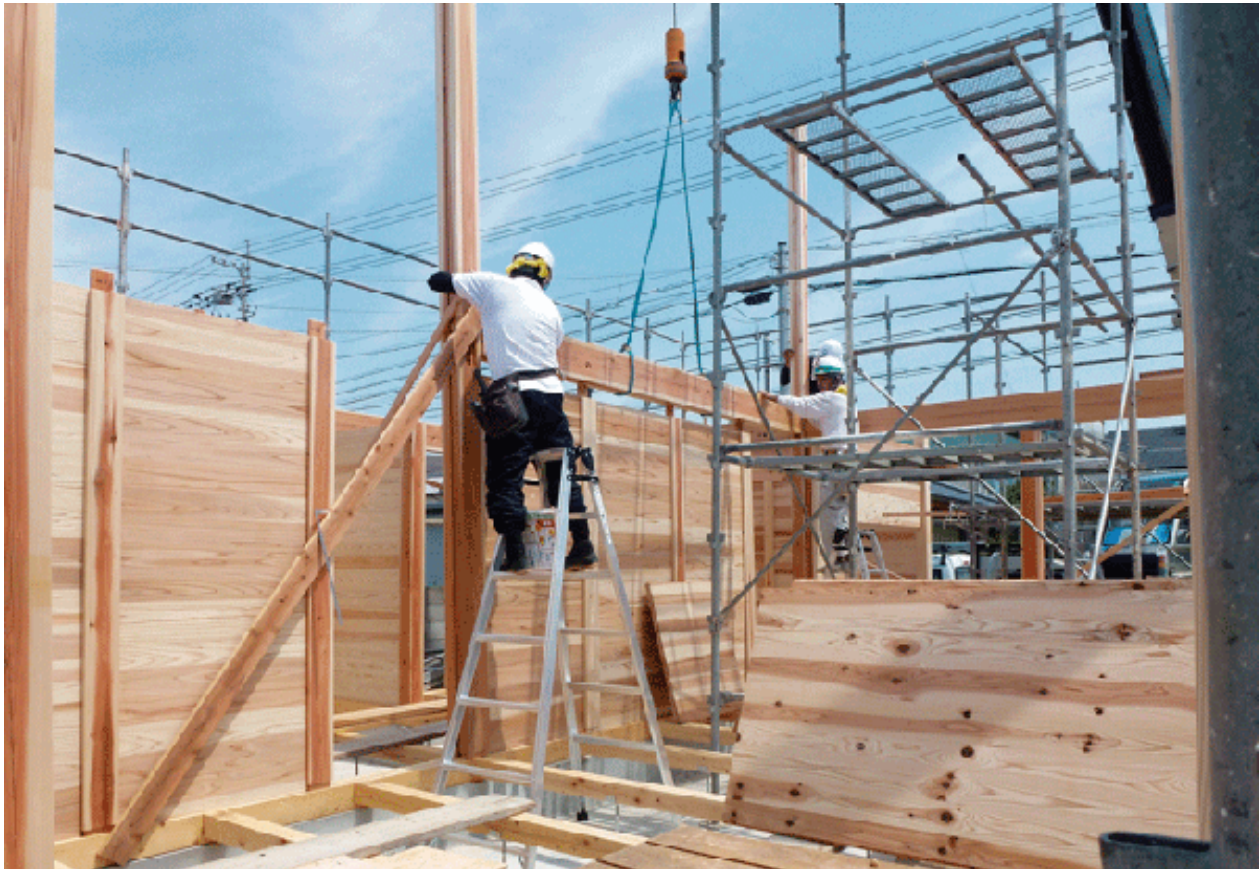
1階柱建て:柱にパネルを落とし込む溝が掘られている
