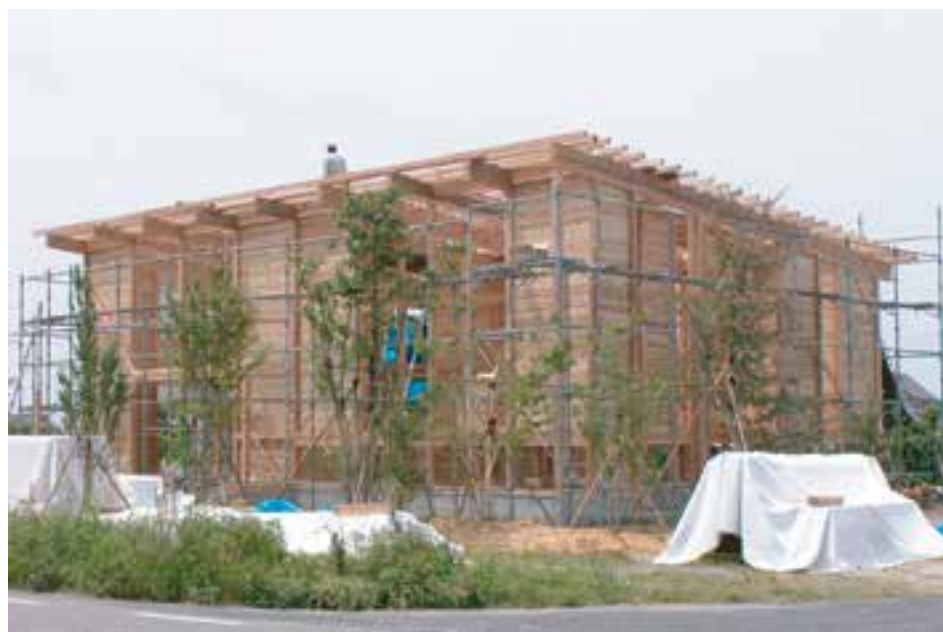
左／鳥取のN邸の建て方全景。落し込み構法だと棟上げの時に既に大体の壁の様子がわかります。 下／岐阜の禪定庵の耐力壁。
