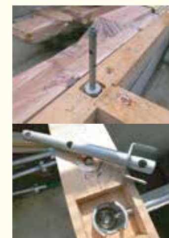
ホールダウン金物のHDCと笠形アンカーボルト。柱・土台・基礎を緊結します。
