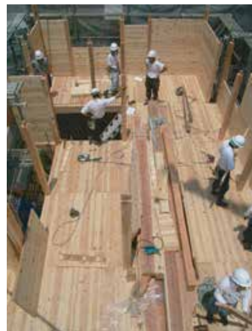
建て方の様子。Jパネルで床を造りながら工事を進めれば、足場にもなり作業性も安定します。
