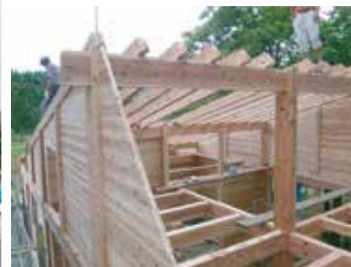
左／鳥取のN邸の建て方全景。落し込み構法だと棟上げの時に既に大体の壁の様子がわかります。 下／岐阜の禪定庵の耐力壁。
