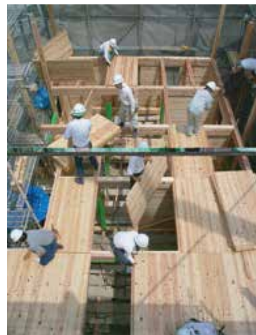
建て方の様子。Jパネルで床を造りながら工事を進めれば、足場にもなり作業性も安定します。
