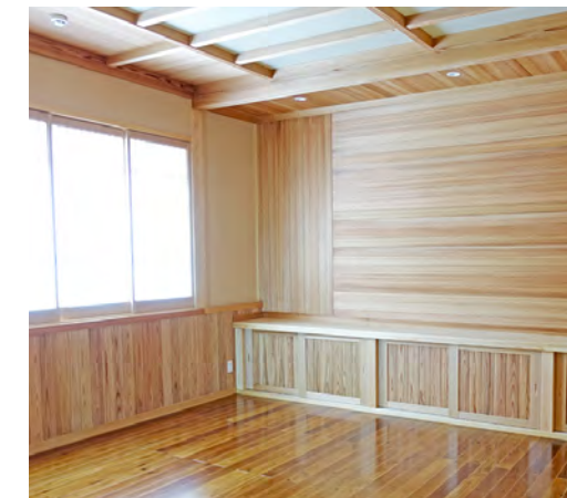
杉の源平を使用。壁面は板目と柱目を使い分けています。
