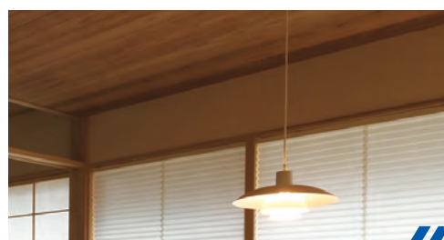
壁と天井の境目に取り付けられた廻縁。
